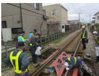
12月10日 社長巡回（穴池場橋梁）
